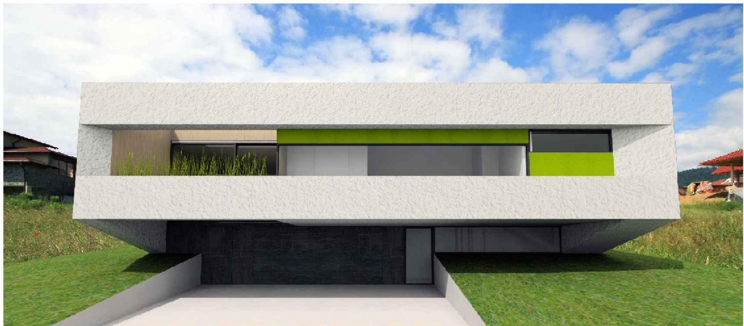
zasunutie suterénu pod hmotu objektu, rampa zarezaná do terénu minimalizuje úpravy svahovitého terénu
